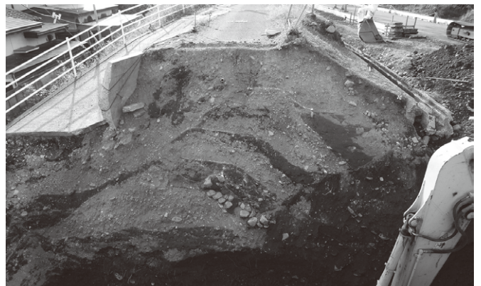
発掘された堤防の例（南アルプス市徳永） 堤防が段階的に、かさ上げされているのがわかる
